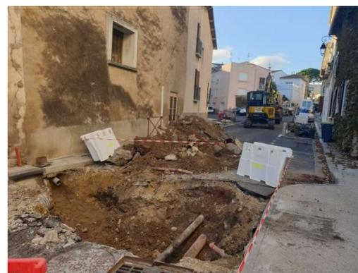
L'affaissement provoqué par une fuite du réseau d'assainissement au carrefour de la RD 13 vient d'être réparé. Le coût des travaux a été pris en charge par la communauté des communes Les Avant-Monts à laquelle nous avons transféré la compétence de l'assainissement communal.
